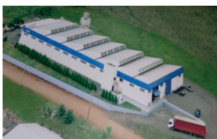
Estrutura fabril em 2011 - 2729,70m 2
