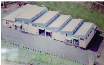
Estrutura fabril em 2004 - 1512,44m 2
