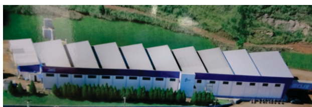
Estrutura fabril em 2014 - 3.293,70m 2
