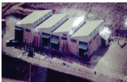
Estrutura fabril em 2002 - 800m 2
