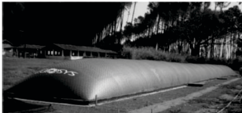
Figura 5 - Representação do biodigestor tipo Canadense.
