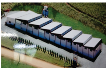
Estrutura fabril em 2010 - 2061,04m 2
